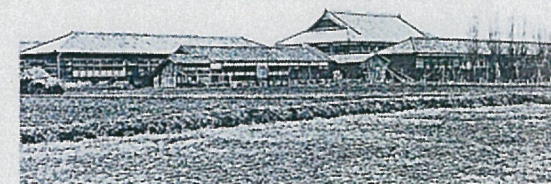
昭和11年に完成した校舎
