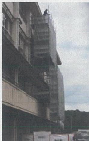
校舎外の足場
